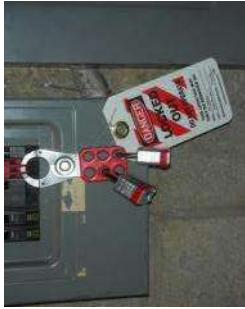
แขนงป้าย Lock out – Tag out ที่ตู้จ่าย ไฟฟ้า
