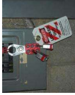
เขวนป้าย Lock out – Tag out ที่ตู้จ่ายไฟฟ้า
